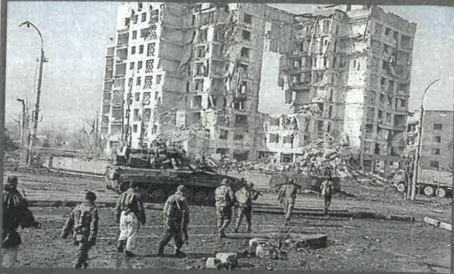
Zerstörte Gebäude in Mykolajiw
